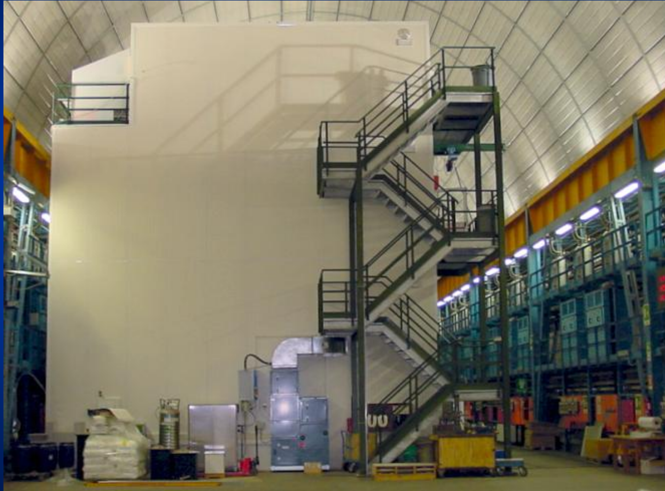
Der drei Stockwerke hohe Experimentalaufbau mit dem Kryostaten.
